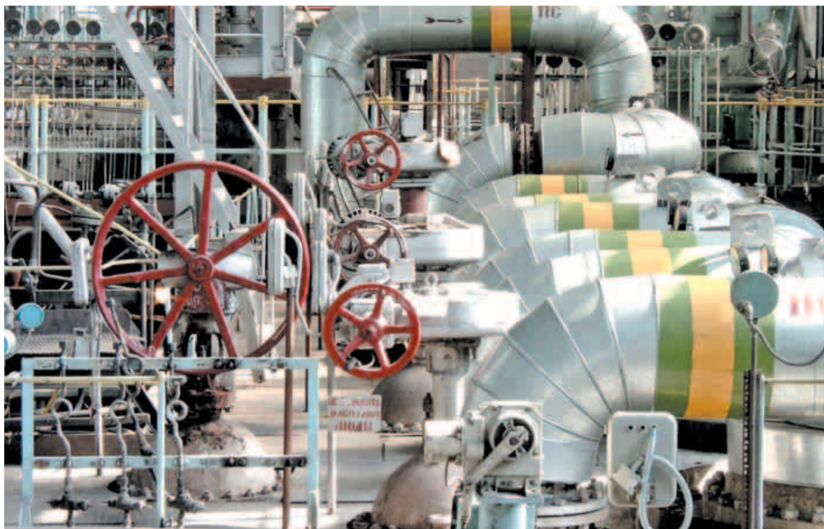
Электростанция и теплосетевой комплекс СГК в городе Кемерово минувшей зимой успешно выдержали испытание длительными морозами.
